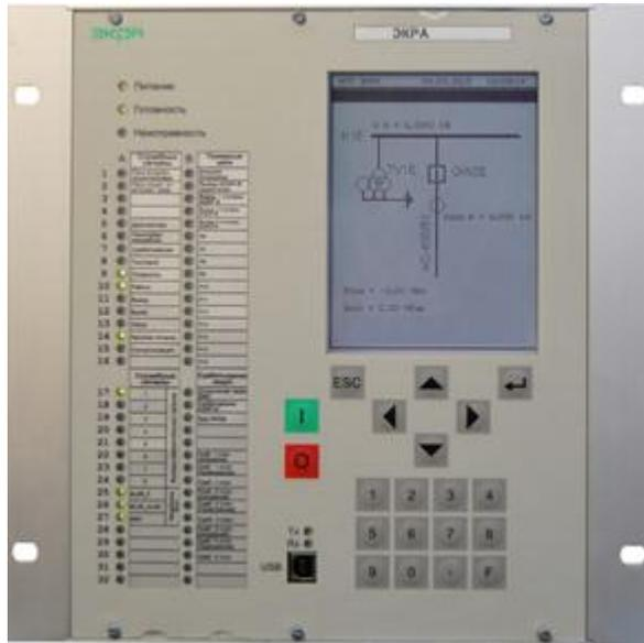
Рисунок 5.13 – Общий вид терминала серии ЭКРА 200
