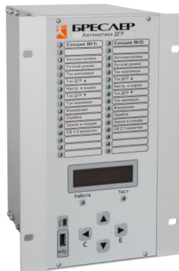
Рисунок 4.1 – Устройство автоматического управления ДГР Бреслер-0107.060
