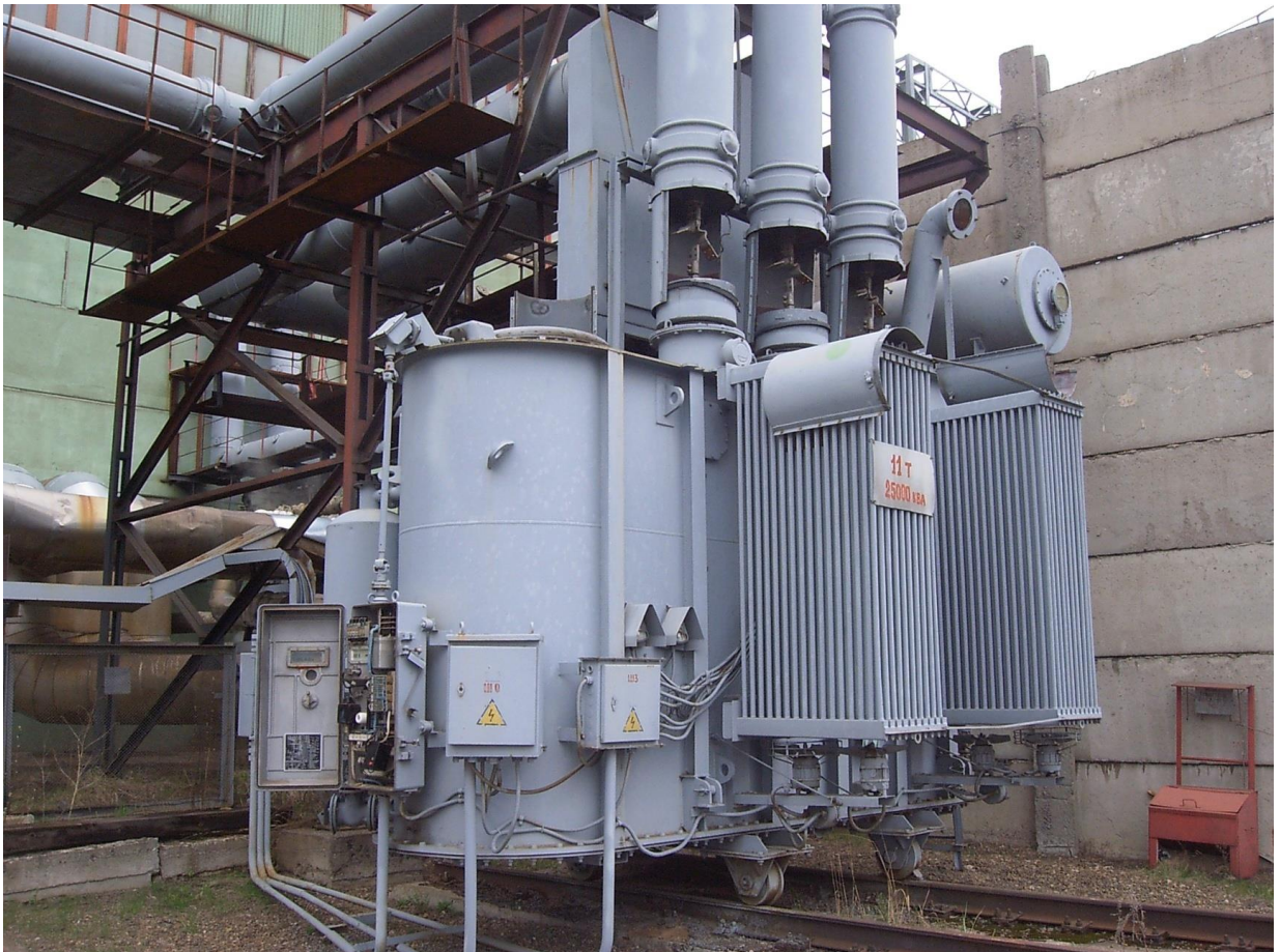
Рисунок 2.1 – Общий вид трансформатора собственных нужд с РПН типа SDV1-630-41/41-W19
