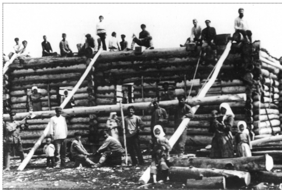
Рис. 2. Постройка дома способом нуме .
