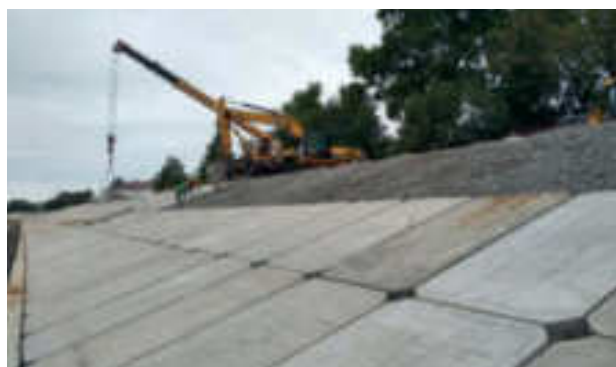
Рис. 6.27. Строительство дамбы на р. Северная Двина
