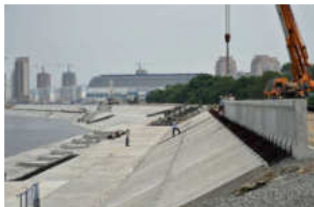
Рис. 6.23. Строительство защитной дамбы в Южном округе г. Хабаровска
