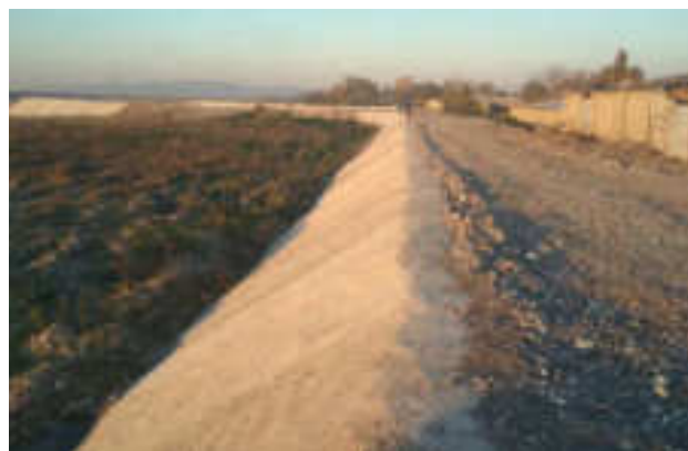
Рис. 6.29. Капитальный ремонт ГТС берега р. Аргун
