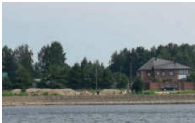
Рис. 6.28. Берегоукрепление Рыбинского водохранилища
