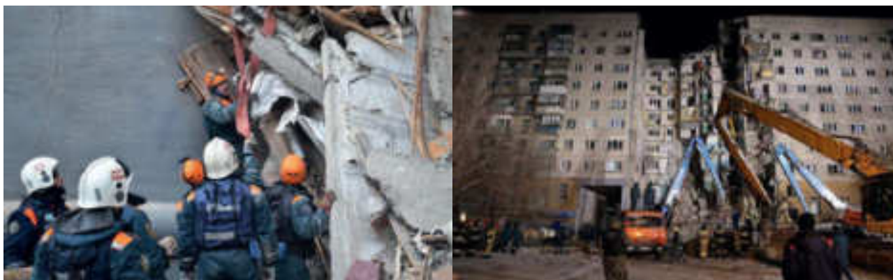
Рис. 1.10. Ликвидация последствий взрыва бытового газа в г. Магнитогорске
